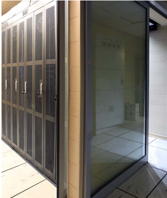
سفارشی‌سازی تجهیزات در صورت وجود ستون (و سایر محدودیت‌های متداول) در فضای استقرار راهروی سرد یا گرم بسته IDC
