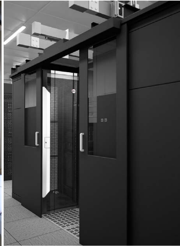
بهینه‌سازی تجهیزات موجود و نیز افزایش تجهیزات جدید در کنار تجهیزات قدیمی های سرمایشی (نظیر رک و سیستم
