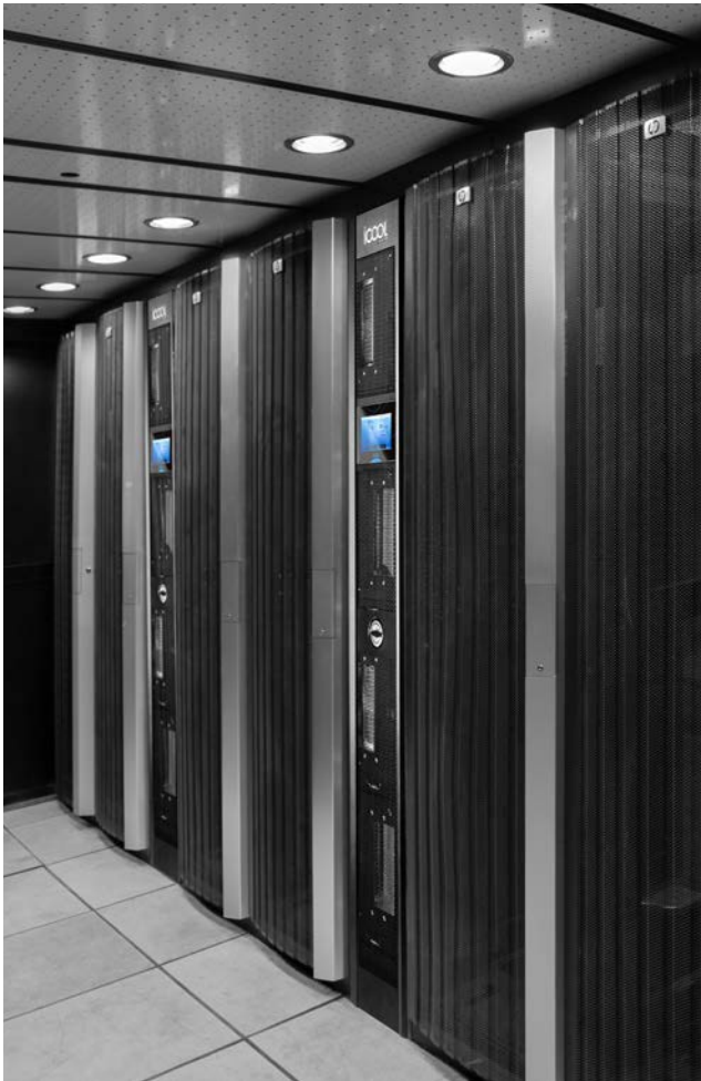
اضافه کردن سیستم‌های سرمایشی به راهروی سرد و گرم بسته iDC
