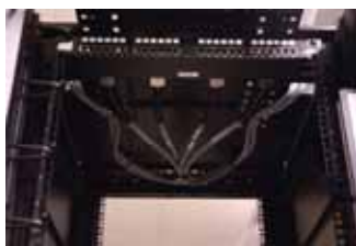
پیچ پنل (patch panel)
